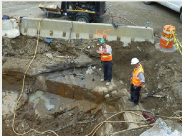
Figur 2. Spräckning med vertikala hål, Manhattan, New York.
