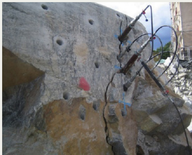
Figur 3. Spräckning av bergblock, Nya Karolinska Solna.
